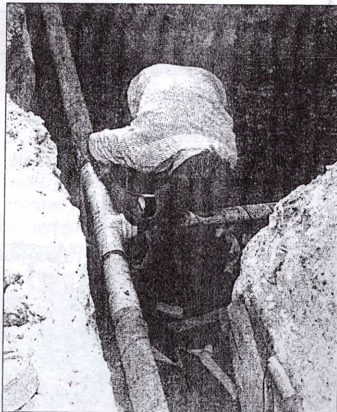
Un trabajador instala cañerías para gas natural
